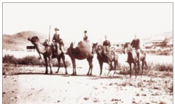
Beim Bau der Leitung bewährten sich Kamele als Lasttiere
